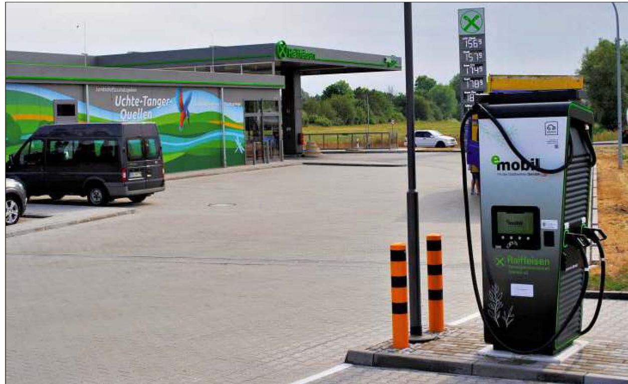
Die Tank- und Raststätte Käthen verfügt seit kurzem über eine Station mit zwei 150kW-Schnell-Ladesäulen. An diesem sogenannten Hypercharger wird mit einer Ladezeit von 20 bis 30 Minuten gerechnet. Foto: Axel Junker
